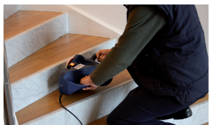
Reinigung von Innentreppen
