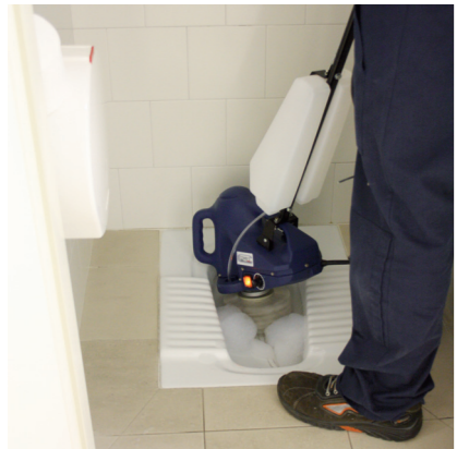
Sanierung von Toiletten
