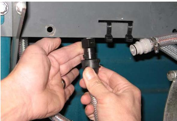
5. Führen Sie den Einlassschlauch des ec-H2O-Systems in einen Behälter mit 19 Liter weißem Essig oder Reissessig. Führen Sie den Auslassschlauch in einen leeren Behälter.
