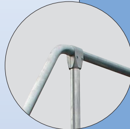
formschlüssiger, bündiger Anschluß von Handlauf zu Geländer
